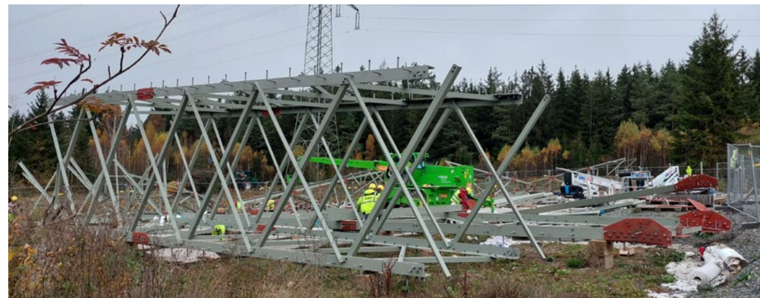
Zusammenbau der Mastteile auf dem Baufeld. Foto: ASF
