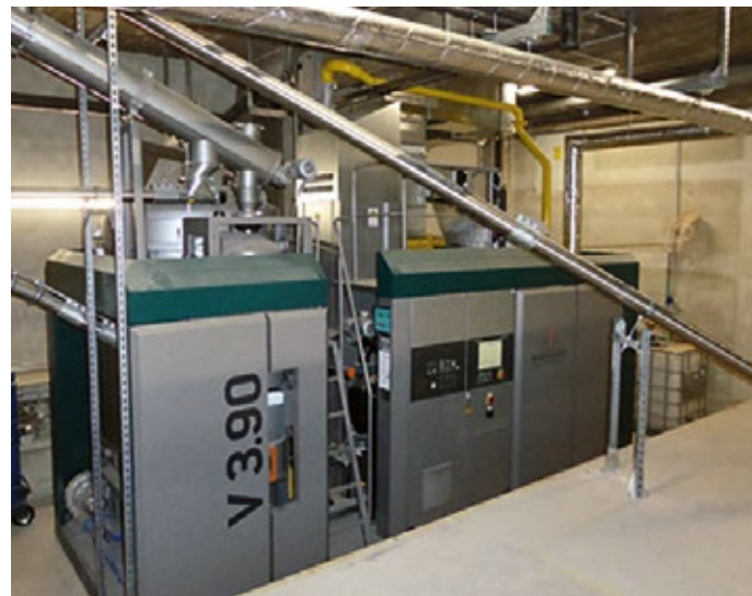
Holzvergaser der Firma Burkhardt im Arzberger Winterling-Standort
